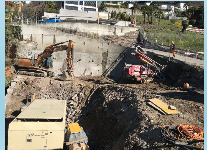
Dopo gli ancoraggi e calcestruzzo proiettato
